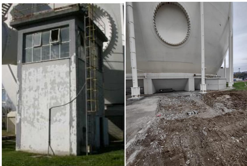
Figura 2.1 Edificio Tiosolfato – prima e dopo la demolizione
