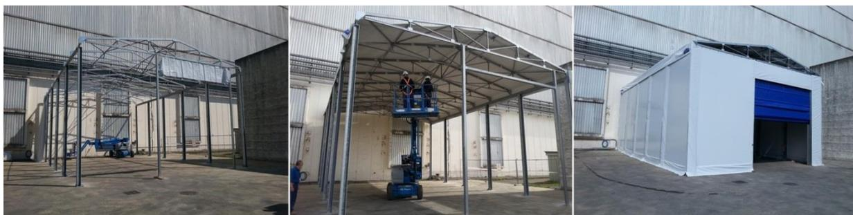
Figura 4.6/2 - Principali fasi costruttive del capannone temporaneo
