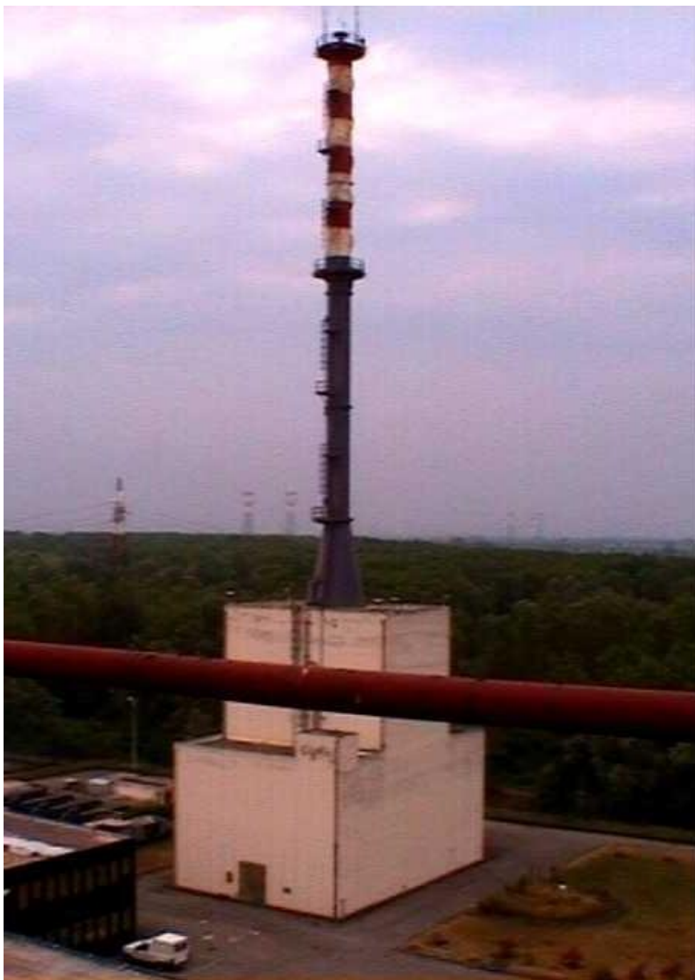
Figura 4.7/2 - Esterno dell'Edificio Off-Gas
